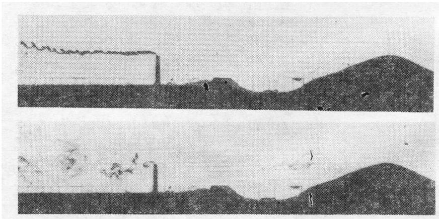
图 4 流场中涡的形成和破碎
